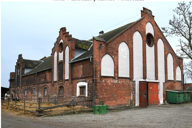
widok w kierunku północno-zachodnim
