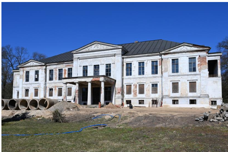
widok w kierunku północno-wschodnim
