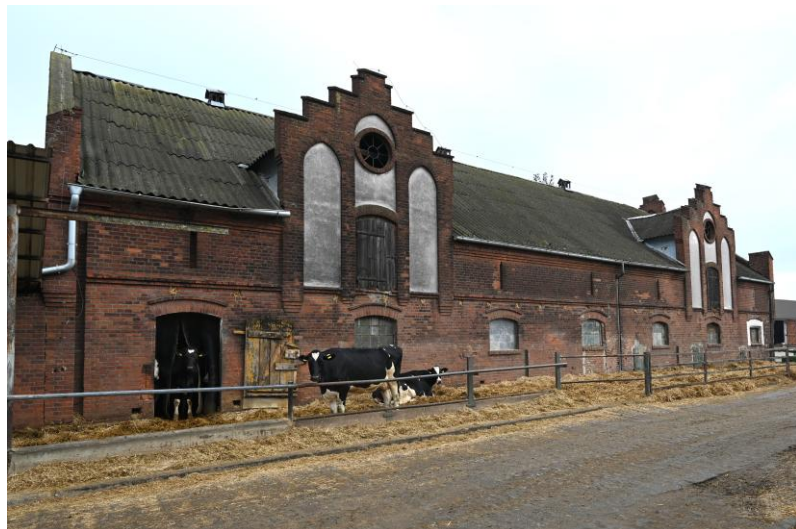
widok w kierunku północno-wschodnim
